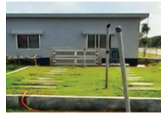
Project Name: 41 Bir Capacity: 100 m 3 /day
